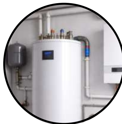
Erneuerung der Heizungsanlage
