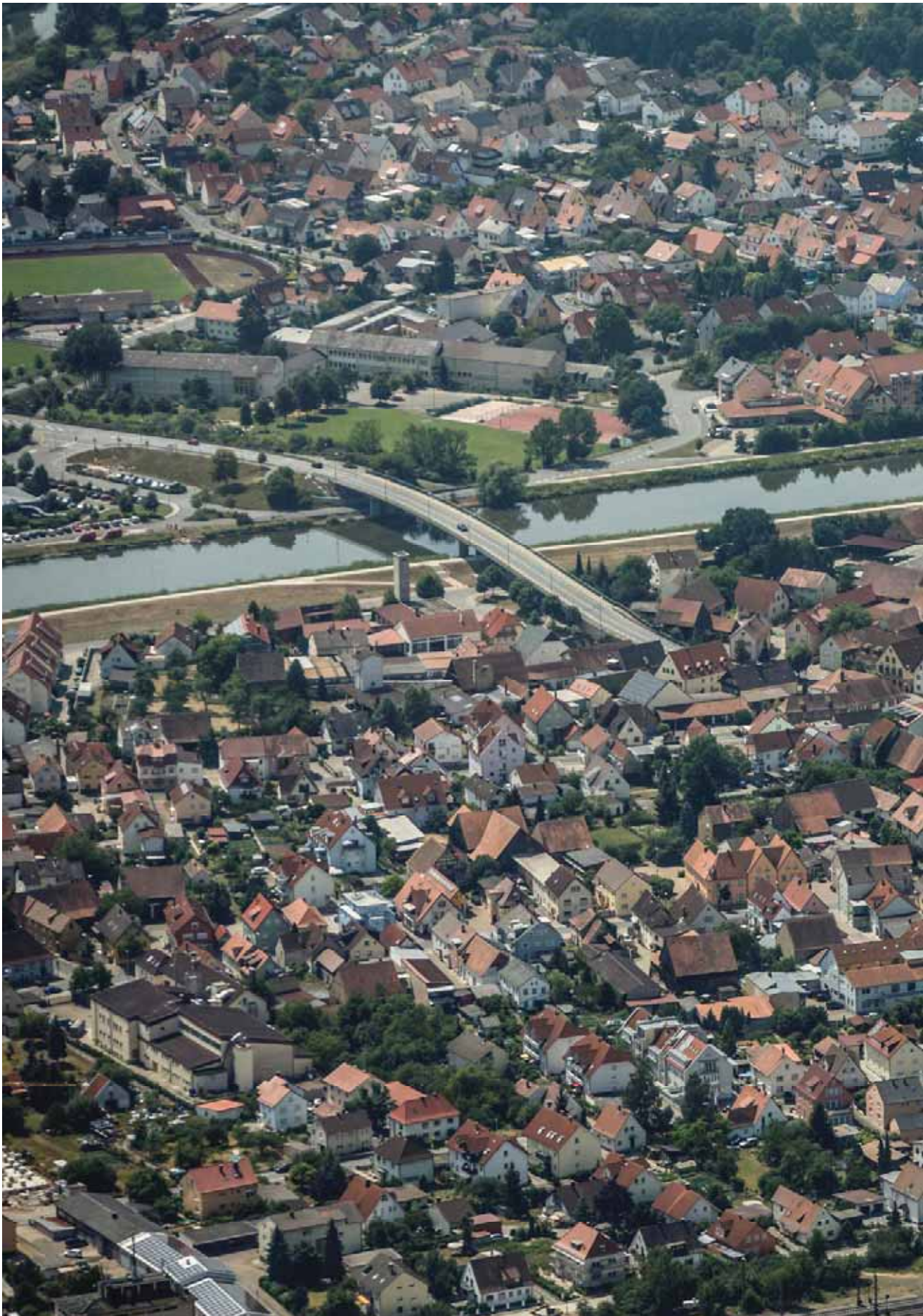
Kanalbrücke von Hirschaid nach Sassanfahrt
